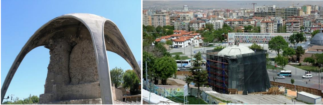
Resim 22 - 23. Kılıçarslan Köşkü kalıntısını örten 1961 yılı yapımı üst örtü ve kaldırılma çalışmaları, 2016 Kaynak: (Arkeofili, 2016), (Önge, 2017)
