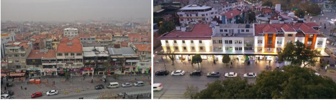
Resim 25 - 26. Alaaddin Tepesi çevresi cephe düzenleme çalışması (solda çalışma öncesi, sağda çalışma sonrası) Kaynak: (Konya Büyükşehir Belediyesi)
