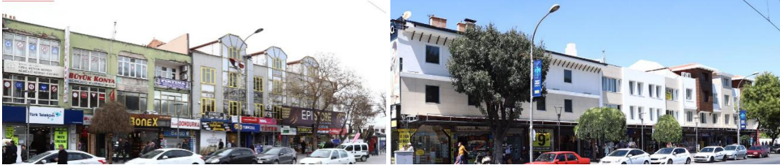
Resim 27 - 28. Alaaddin Tepesi çevresi cephe düzenleme çalışması (solda çalışma öncesi, sağda çalışma sonrası) Kaynak: (Konya Büyükşehir Belediyesi)
