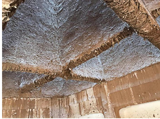
Şekil 8. Rüzgâr bacaların içindeki kanalları oluşturan bölme duvarlar ve ahşap ve hurma ipinden yapılan ana strüktür (Yazar, 2022)
