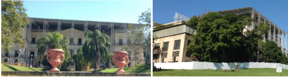
Şekil 10: Ulusal Müze’de Yangın Sonrası Yapılan Geçici Çatı ve Çevre Koruma Duvarları [URL 10].
