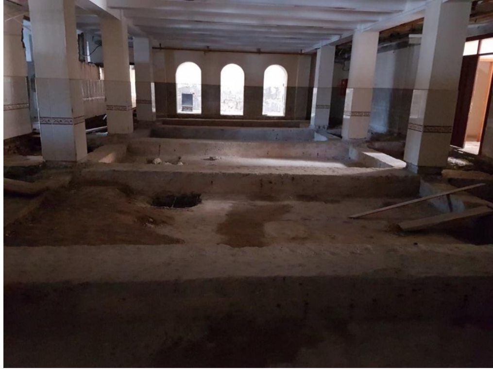
Fotoğraf 14: Kabataş Erkek Lisesi Yatakhane Binası Zemin Kat, Sofa, 2017.
