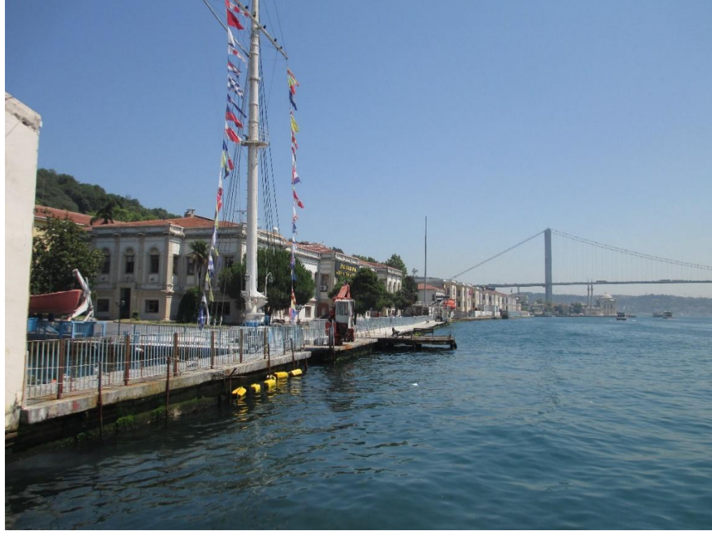
Fotoğraf 9: Ziya Kalkavan Anadolu Teknik ve Mesleki Lisesi Deniz Cephesi, 2017.
