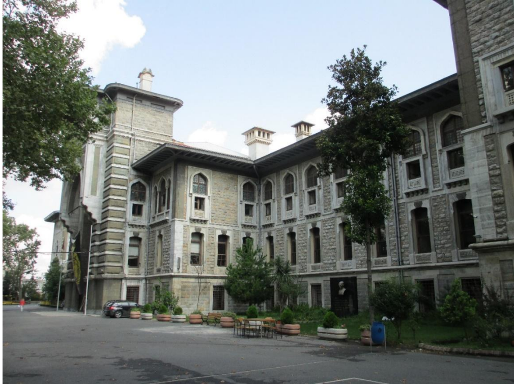
Fotoğraf 12: İstanbul Erkek Lisesi Giriş Cephesi, 2017.
