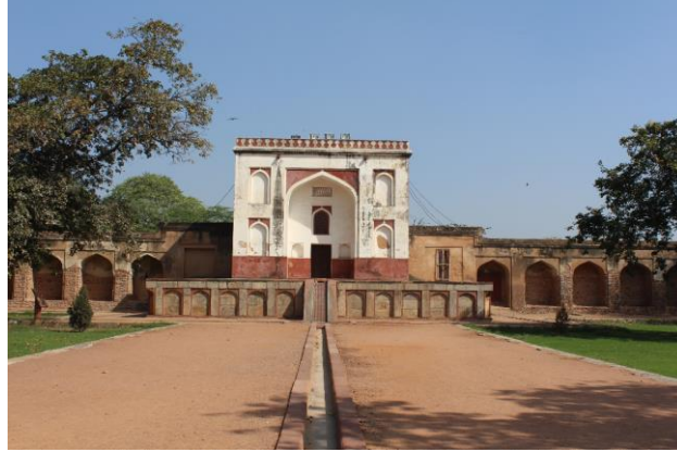
Fotoğraf: 33 Hümayun Türbe Bahçesinde Bulunan Hamamın Güney- Kuzey Cephe Genel Görünüşü (Özler,2016)
