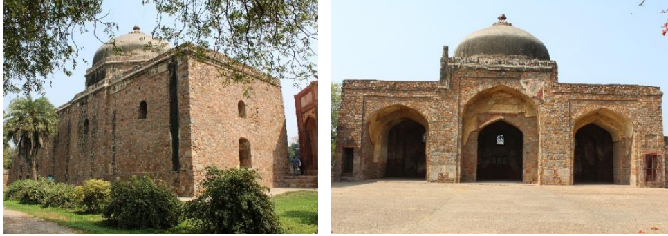
Fotoğraf: 20-21 Efservalı Camisi Arka Cephe ve Ön Cephe Genel Görünüşü (Özler, 2016)
