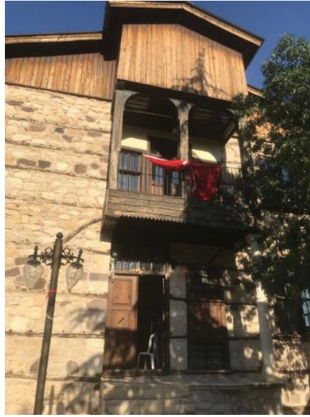
Fot.3: Arapgir Kaşkal Konağı Batı Cepheden.
