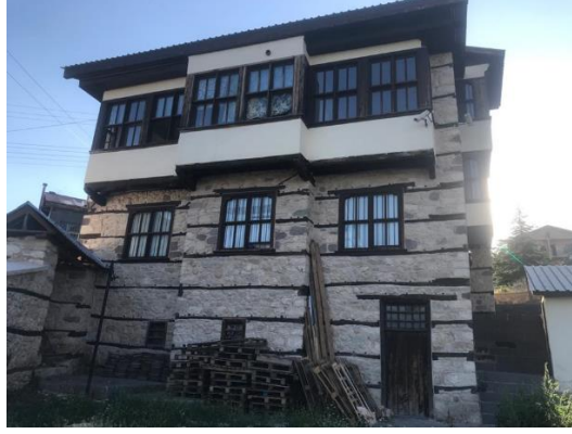
Fot.2: Arapgir Kaşkal Konağı Doğu Cephe.
