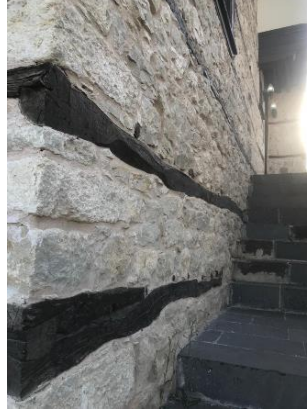
Fot.7: Arapgir Kaşkal Konağı Kuzey Cephe Duvarına Bitişik Taş Basamaklı Merdiven.
