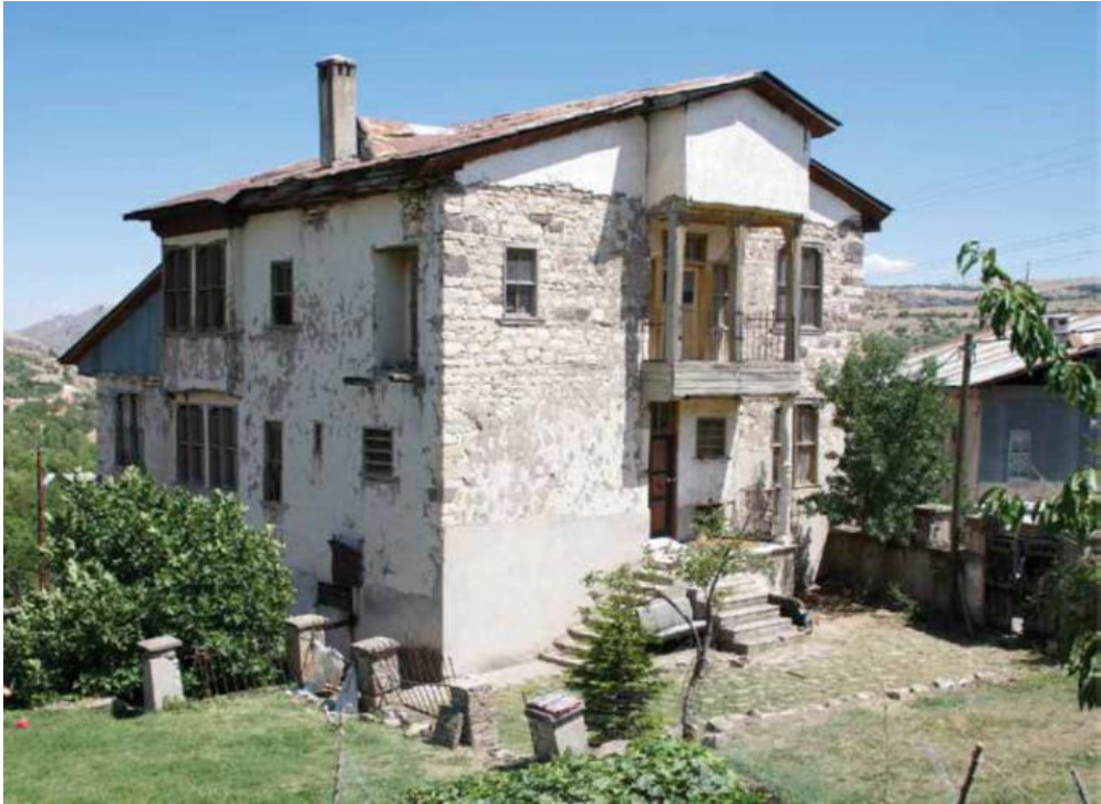
Fot.1: Arapgir Kaşkal Konağı Son Restorasyondan Önceki Durumu (K. Eyüpgiller'den).
