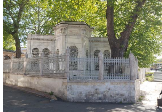
Resim 17. Türbenin ön cephe fotoğrafı (Coşkun, 2024)
