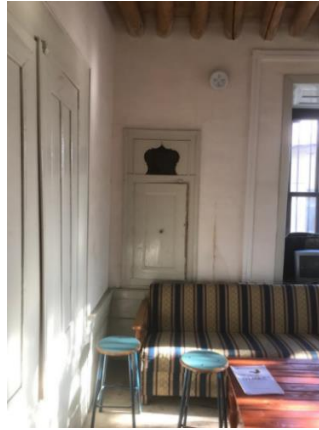
Fot.11: Arapgir Kaşkal Konağı Ahşap Yüklük, Dolap ve Kandillik.
