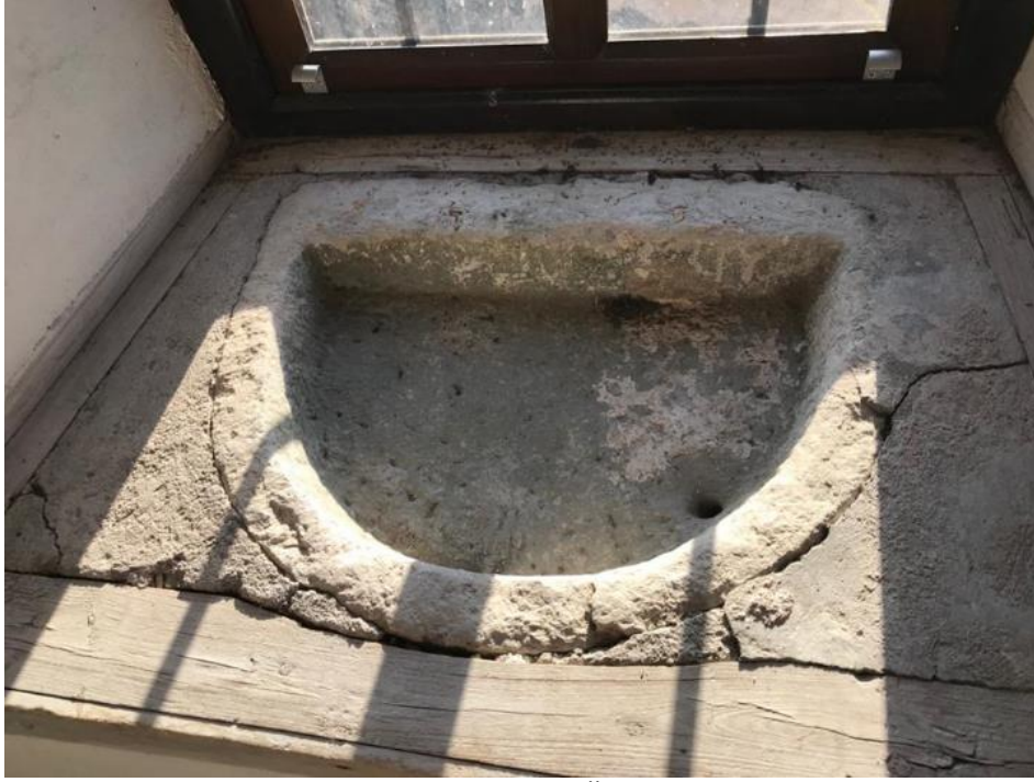
Fot.15: Arapgir Kaşkal Konağı Pencere Önünde Taştan Oyma Lavabo.
