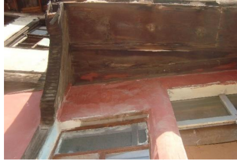
Foto 20: "S" ve "C" şeklinde kıvrımlı çıkma taşıyıcıları (Mavi Mühendislik Mimarlık arşivinden)
