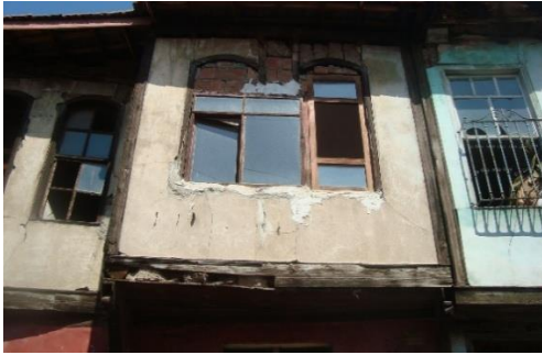
Foto 19: Konutun gönye çıkması
