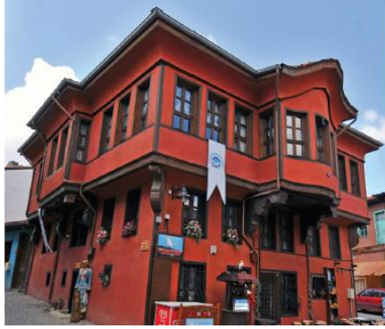
Foto 5: Odunpazarı ahşap karkas arası kerpiç dolgulu ev örneği (Yakut, 2016: 53 )
