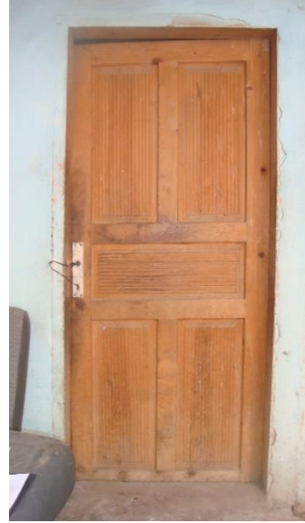
Foto 33: Ahşaptan yapılmış kapı
