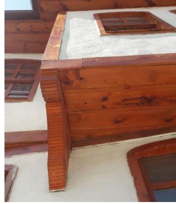
Foto 18: "S" ve "C" şeklinde kıvrımlı çıkma taşıyıcıları
