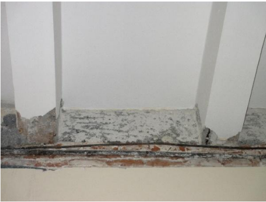
Fotoğraf 19: Kabataş Erkek Lisesi, Özgün duvar-Betonarme döşeme detayı, 2017
