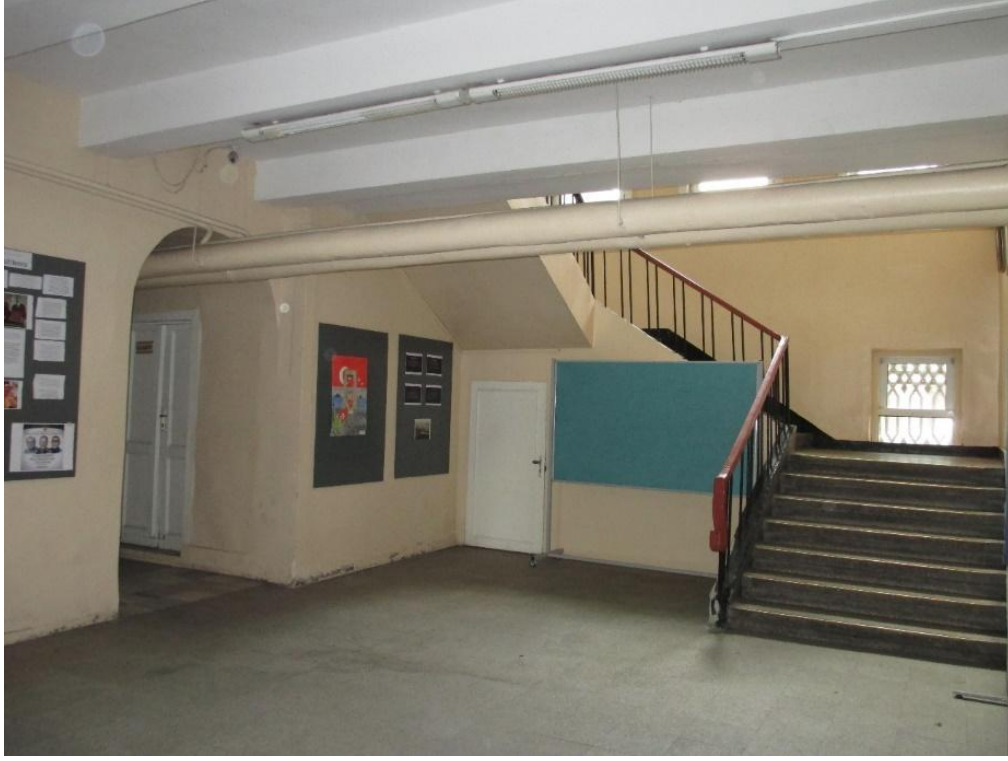
Fotoğraf 15: Beşiktaş Anadolu Lisesi, Zemin Kat, 2017.
