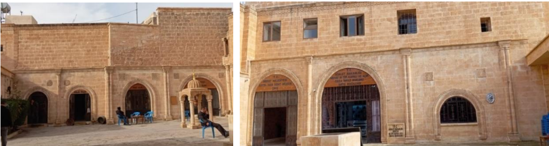
Şekil 9: Estel Hanı Batı Cephesi (Solda), (2023), Estel Hanı Doğu Cephesi (Sağda) (2023)
