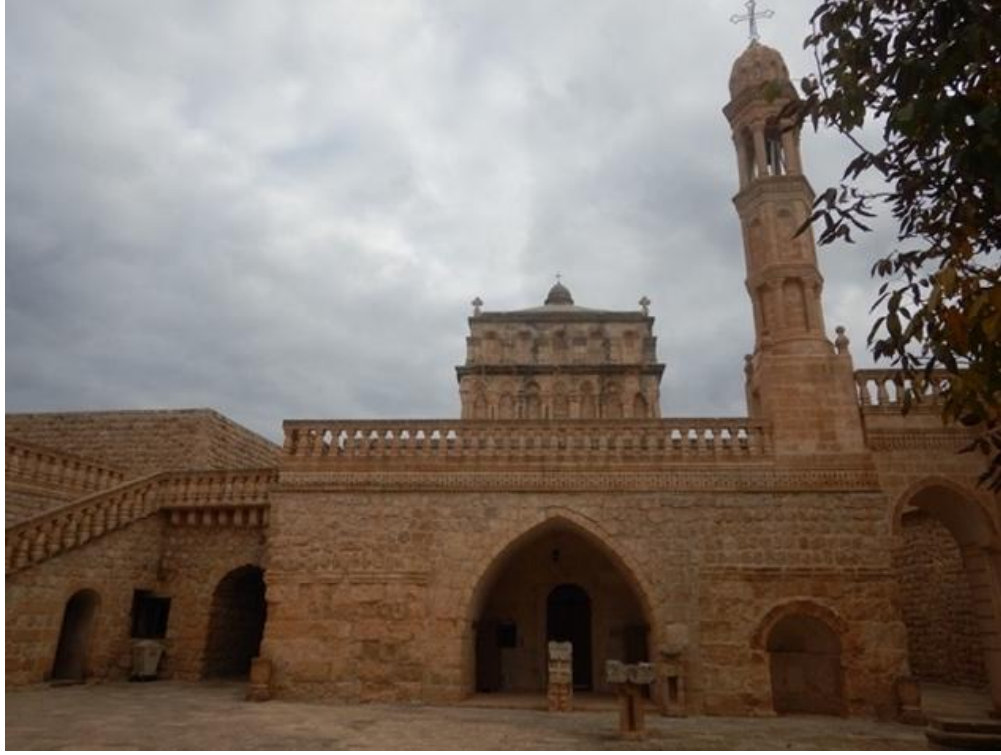
Şekil 9: Meryem Ana Kilisesi batı cephesi, 2022
