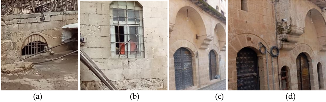
Şekil 25: (a), (b) Hayvan Hanı korozyon oluşumu, (c), (d) Gelüşke Hanı kapı, pencere korozyon oluşumu, (2023)
