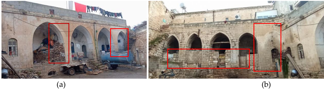
Şekil 15: (a) Hayvan Hanı Betonarme Ek (2023), (b) Hayvan Hanı Revak Kapatılması, Örülen Duvarlar (2023)
