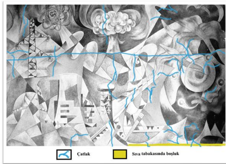
Image 9: f) Damage to the plaster layer - Part 3 (F: Seda Kartal).
