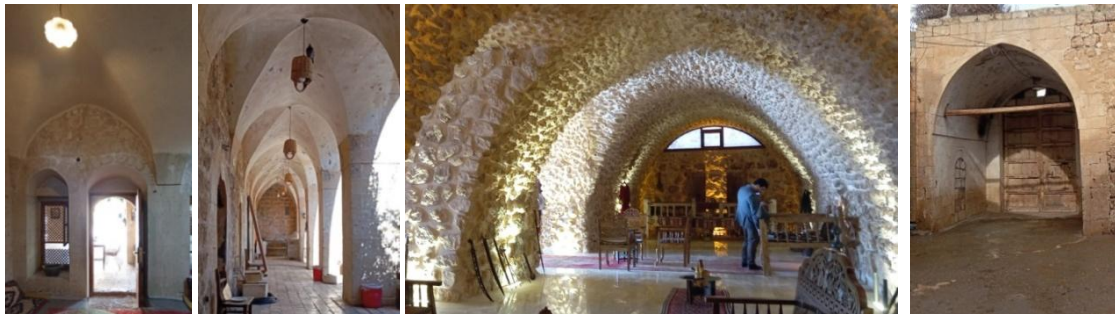
Şekil 14. ( a ) Gelüşke Hanı Çapraz Tonoz, (b) Revaklar, (c) Estel Hanı Beşik Tonoz, (d) Hayvan Hanı Giriş Kapısı Sivri Basık Kemer (2023)
