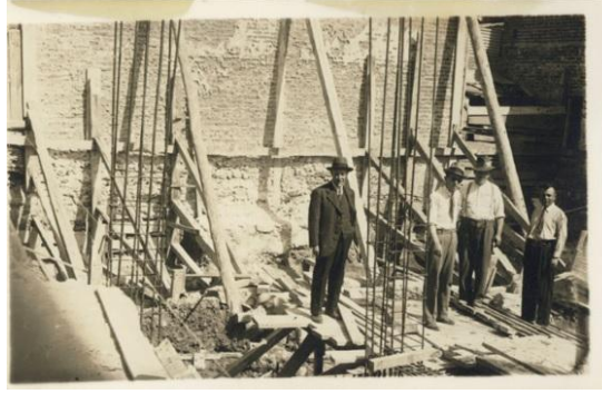
Şekil 17: Betonarme sömellere ilk beton dökülüyor ( https://archives.saltresearch.org , 2022).
